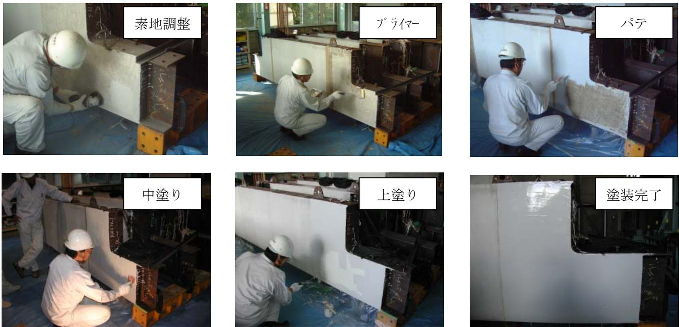
図 1 塗装施工状況
