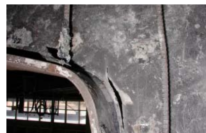
図3 FC1内部の鋼桁き裂
