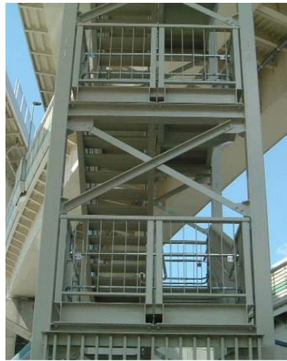
写真-1 斜材設置部
