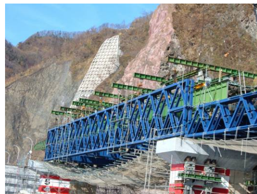
写真-1 架設桁を用いた仮橋の架設
