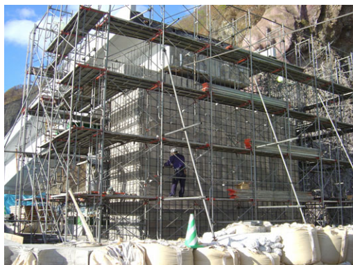
写真-3 P-3 橋脚補修状況
