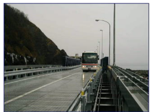
写真-4 供用を開始した大森大橋
