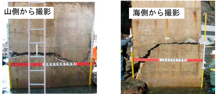
写真-3 P3 橋脚損傷状況
