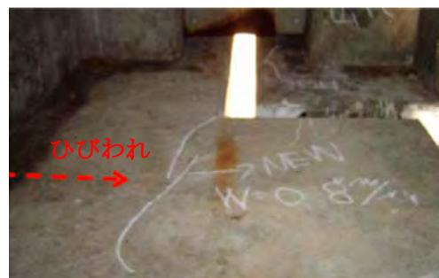
写真-5 ラーメン箱桁内部の損傷状況
