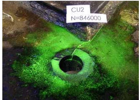
写真3 上フランジカバープレートからの疲労き裂
