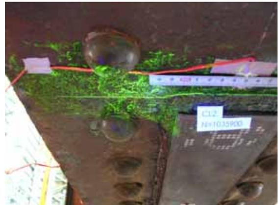
写真2 下フランジカバープレートからの疲労き裂
