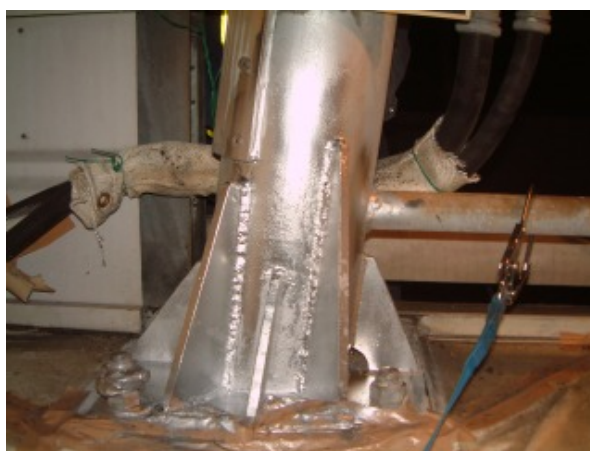
補強リブによる補修
