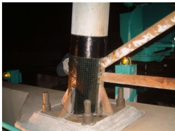
炭素繊維シートによる補修
