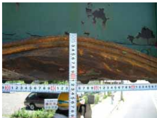
写真１ 衝突による変形事例
