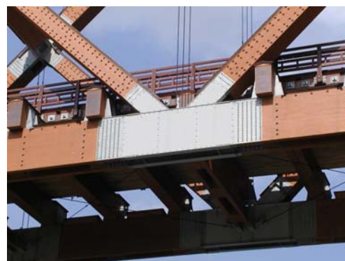
写真-2 大断面集成材の接合部
