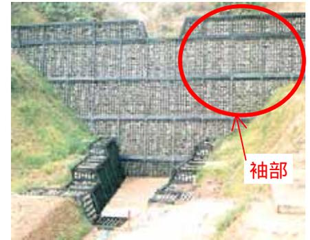
写真-1 鋼製枠砂防えん堤
