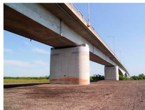
写真-4 現在の十勝河口橋
