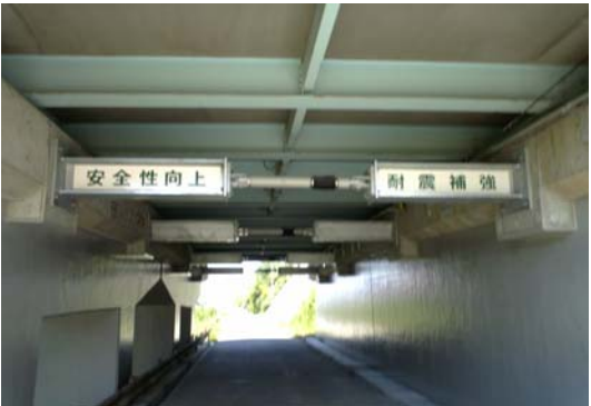
写真-1 ダンパーの設置状況（4箇所）
