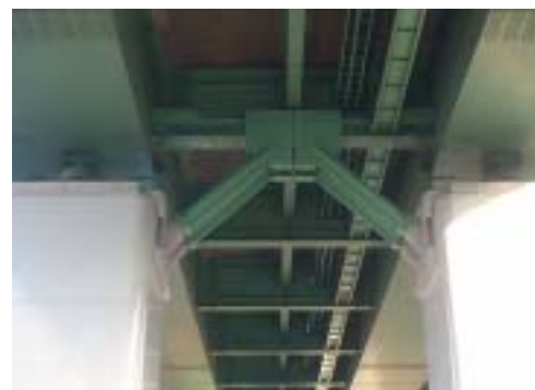
写真 1 座屈拘束ブレース取付け状況
