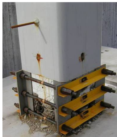
写真1 鋼板タイプ終局
