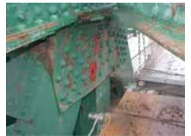
図 3. 腐食劣化の例
