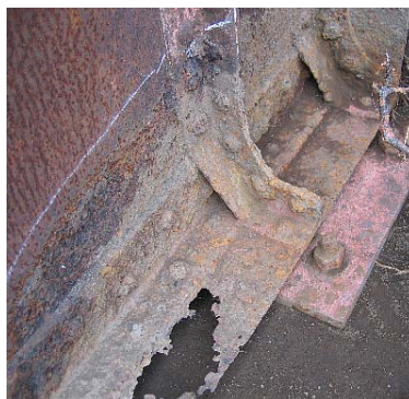
写真-2 主桁（支点部）
