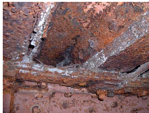
写真-3 床版－桁結合部（桁内面）
