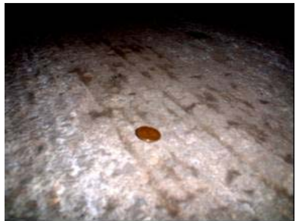
写真 - 1 アスファルト切削完了後の床版上面 床版上面に舗装切削機による筋状の切削痕と アスファルト分の残滓が視認できる。
