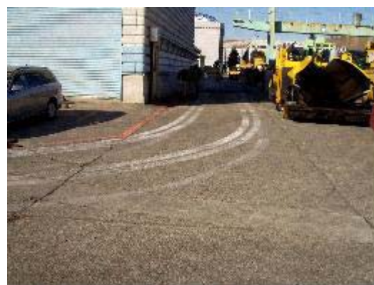
写真 - 2 施工範囲外への材料の付着状況 試験施工現場（写真奥）からアスファルト合材を搬入したトラックが回送されたあと、路面に材料の痕跡が残されている。
