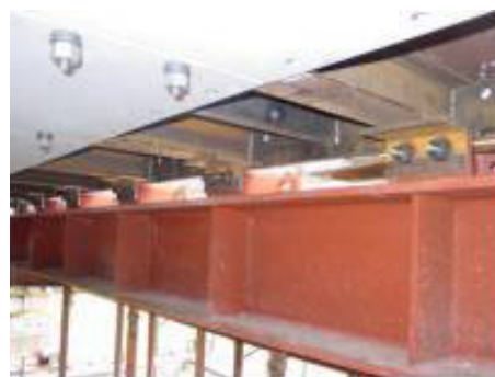
写真3 継手連結
