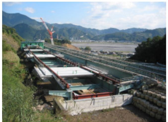
写真-1 移動式型枠支保工移動前：コンクリート打込み中 写真-2 移動式型枠支保工移動後：コンクリート打込み完了
