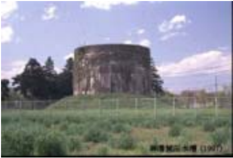
図—1 麻溝減圧水槽 (神奈川県相模原市)
