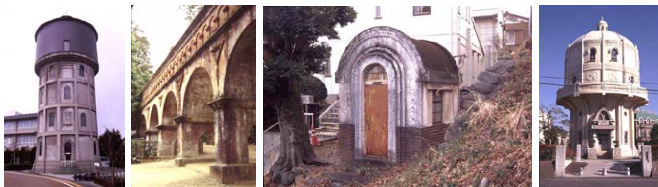
図—3 土木へのアプローチ・モチベーションを誘発しうる近代水道施設の例 （左から、高岡市上水道旧清水町浄水場、南禅寺水路閣、桐生市低区量水室、水戸市低区配水塔）
