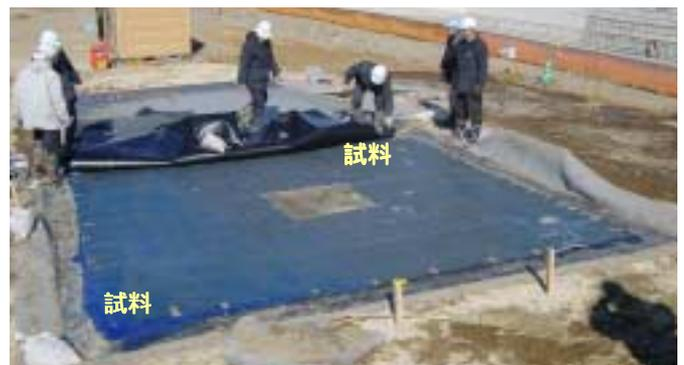
写真-9 二重シート内の充填状況と試料採取位置
