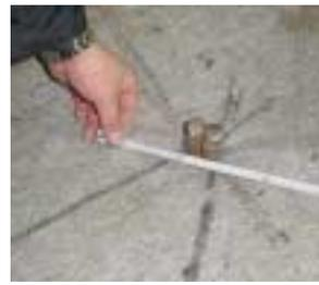
写真-4 遮水ライナーの破損
