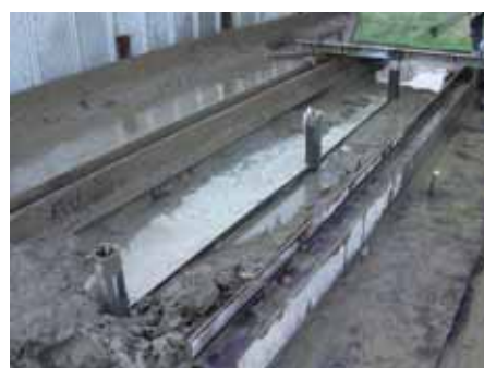
図7 遮水パネル打設完了後の状況
