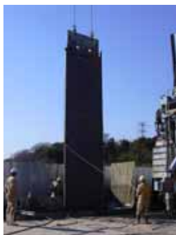
図6 遮水パネル打設状況
