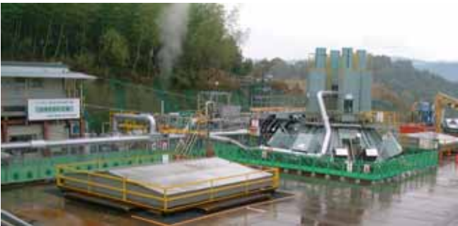
図－1 現地無害化处理状況
