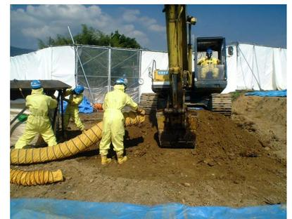
写真-1 汚染土壌の掘削状況
