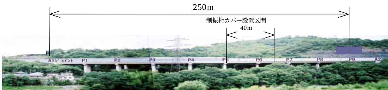
写真-2 実験対象とした高架道路橋
