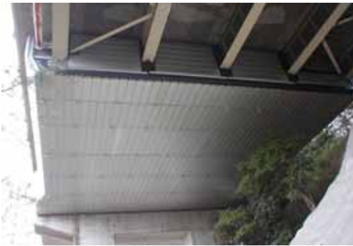
写真-3 制振桁カバー設置状況
