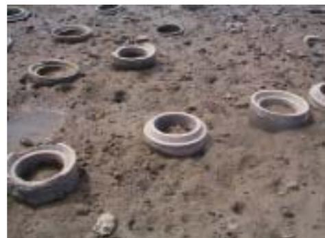
写真 1 透水杭の設置状況
