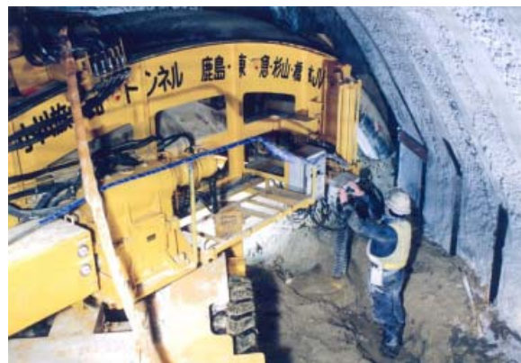
写真-2 BAF工法施工状況
