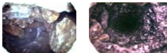
写真-2 孔内映像 水穿孔（自立せず） 薬液濃度：1.5%（自立）
