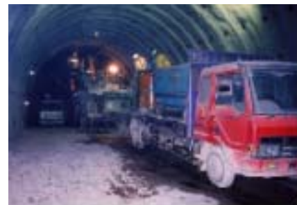
写真-1 孔壁自立工法試験施工状況
