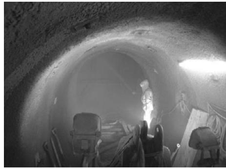
写真-1 粉じん抑制剤使用時吹付状況
