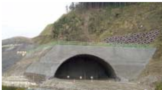
図 6. 対策工完了（坑口部上半）
