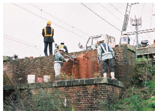
図1 コア試験体の採取状況
