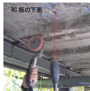
写真-3 腐食度調査の概況
