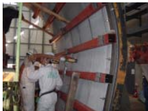
写真 - 1 模擬試験体への打設状況
