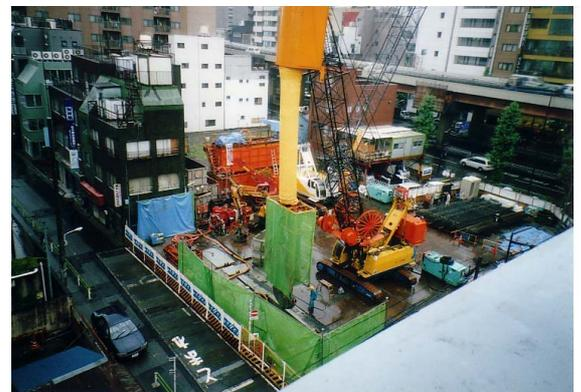
写真-1 地下連続壁施工状況
