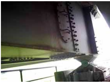
写真-1 端横桁の状況
