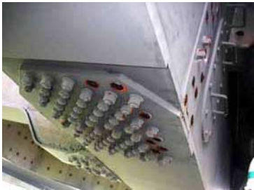
写真-2 F11T 遅れ破壊
