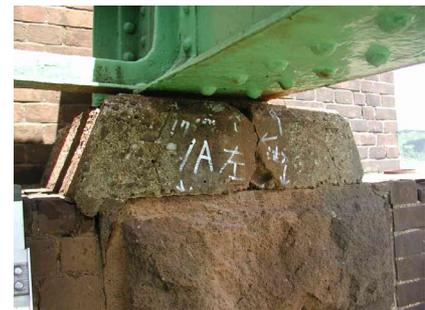
写真-2 沓座モルタルの亀裂
