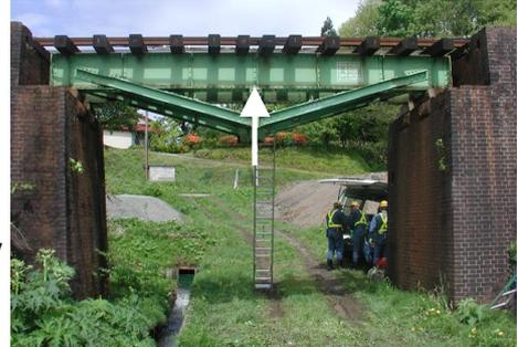
写真-1 フィンク補強桁
