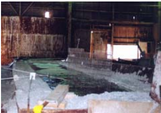
写真－1 溶融アルミメッキの施工
