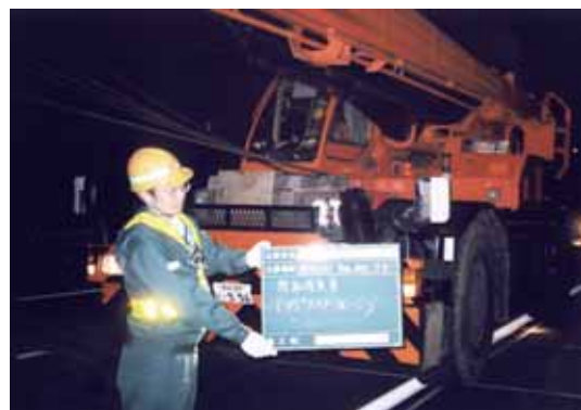
写真-1 45tラフタークレーン載荷状況
