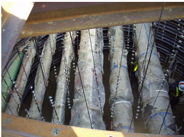
写真-2 立坑内既設配管状況
