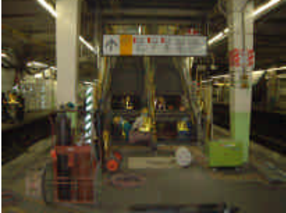
図－4 既設階段撤去作業（夜間）
