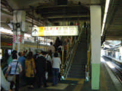
図－3 特殊鉄骨仮設階段
