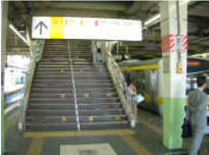
図－2 既設階段（工事前）
