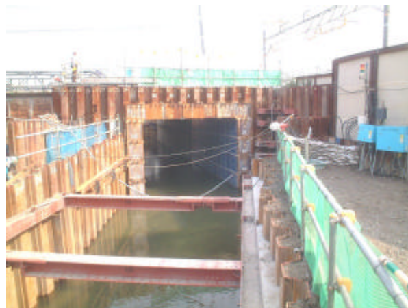
写真-1 仮水路切替状況（下流側より）
