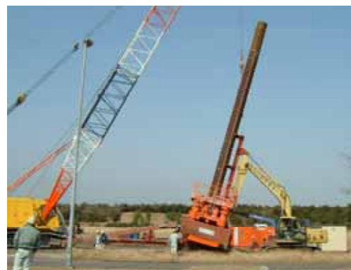
写真-2 斜杭施工状況
