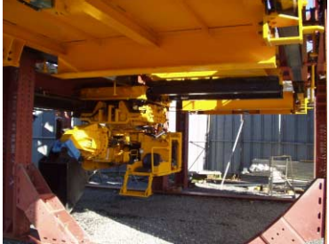
写真-3 横行状況
