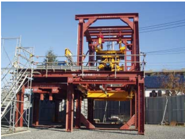
写真-2 吊上げ状況
