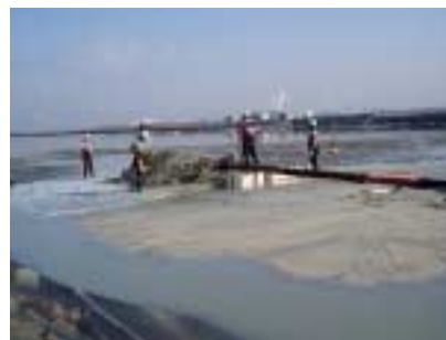
図-5 覆砂施工状況図
