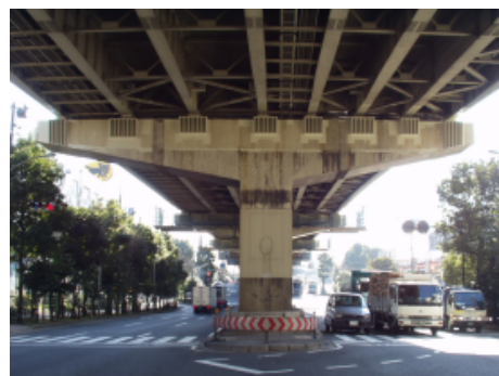
本線 鋼桁 鋼製橋脚
