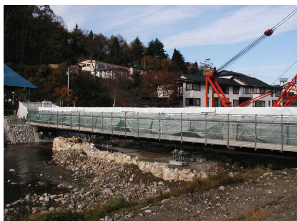
写真 - 4 U 桁全体の養生状況
