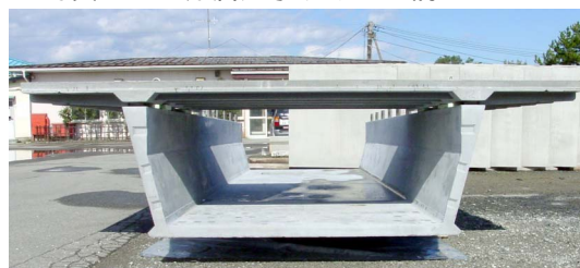
写真 - 2 部材断面
