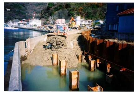
写真-2 処理土の打設状況
