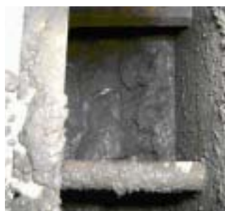
良好な生コン状態
