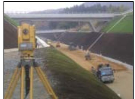
写真-1 3D-MC による施工状況例
