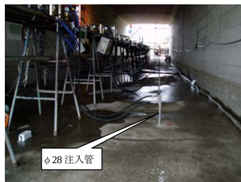
写真.1 道路 BOX 注入管設置状況
