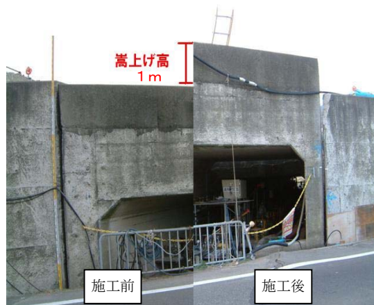
写真.2 水路 BOX2 施工前と施工後
